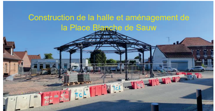
Fin des travaux du Centre Bourg avec les phases "Sécurisation de l'école du Bidoir" "Réfection de la Rue Alexandre Dubois" et "Pourtour de la Halle"
