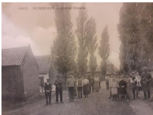
La rue du Grand Chemin
